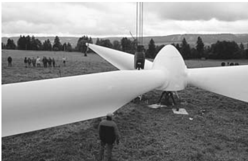
Assemblage des pâles.
