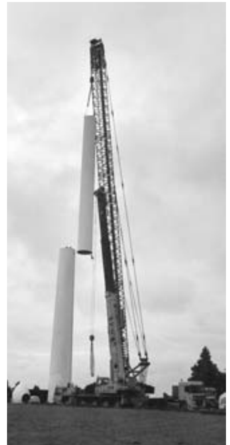
Montage du mât.
