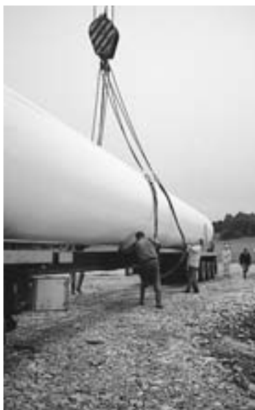
Déchargement du mât.
